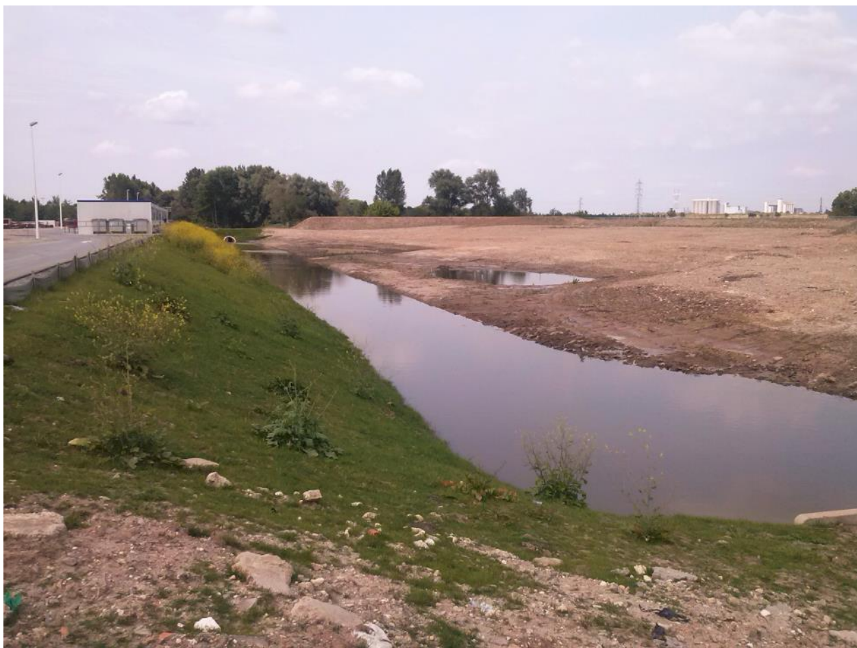
Figure 40 : Vue des terrassements réalisés en 2013 (INGEROP)
