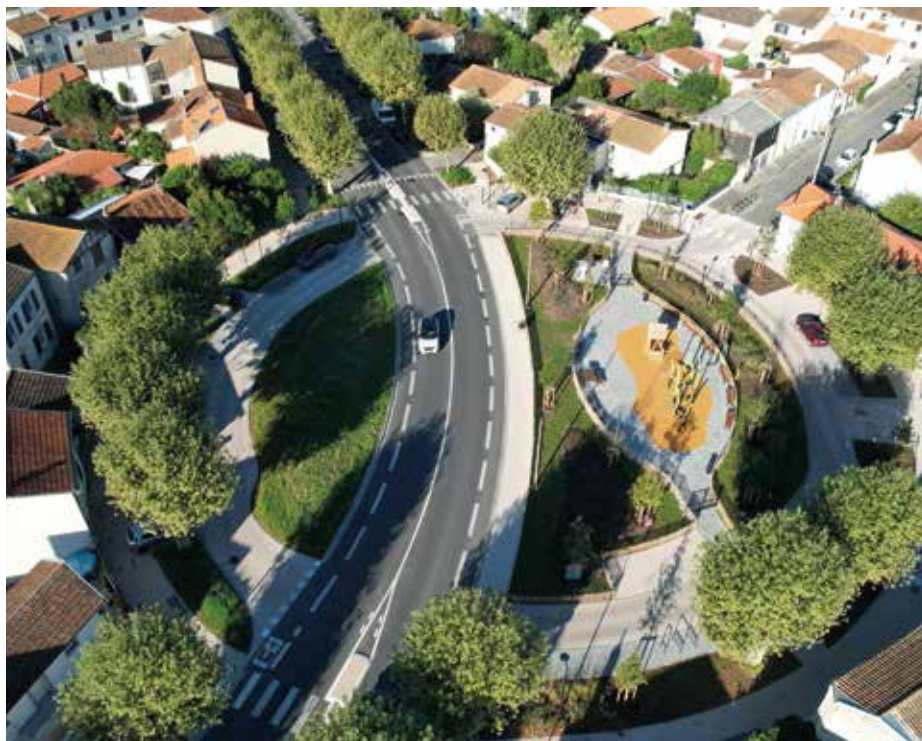
↑ La place Mareilhac, un nouveau lieu de fraîcheur grâce à la désartificialisation de 800 m 2 de sols, la plantation de 31 arbres et plus de 700 arbustes...
