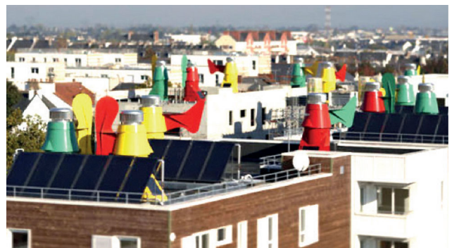
Deux opérations emblématiques de la ventilation naturelle en logement : Saint Nazaire et Bedzed 1. Atelier Philippe Madec
