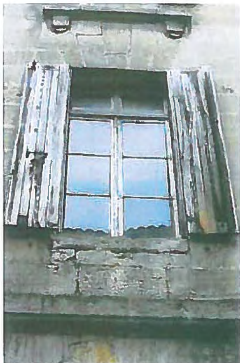
Bat A – Travée gauche. R+1. Menuiserie bois (croisée + volets). Plate-bande appareillée.
