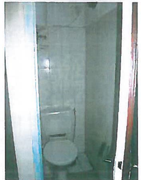
WC communs RdC
