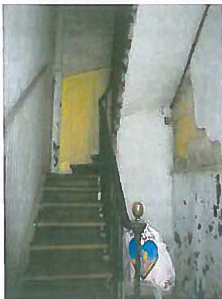
Cage d'escalier au RdC
