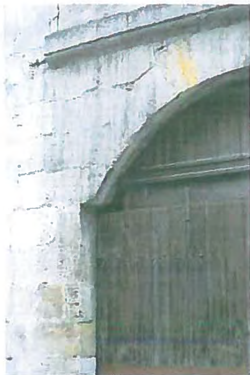
Bat A – Travée gauche. R+1. Menuiserie bois (croisée + volets). Plate-bande appareillée.
