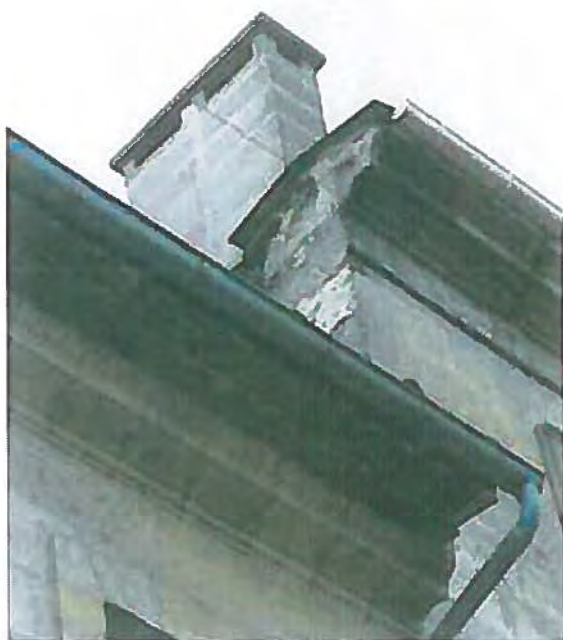
Bat A – Toiture. Détail angle façade. Souche de cheminée en boisseaux ciment. Gouttière en PVC
