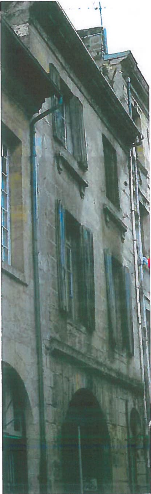
Bâtiment sur rue; Façade
