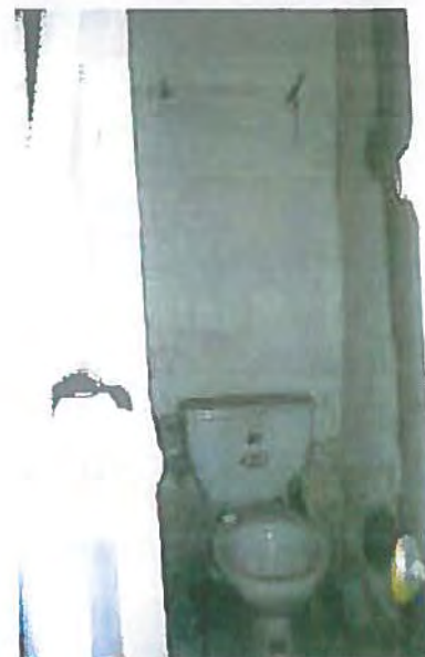
WC au grenier
