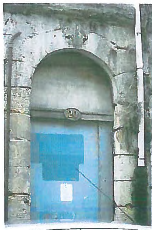
Bat A – Porte d'entrée de l'immeuble. Imposte cintrée.
