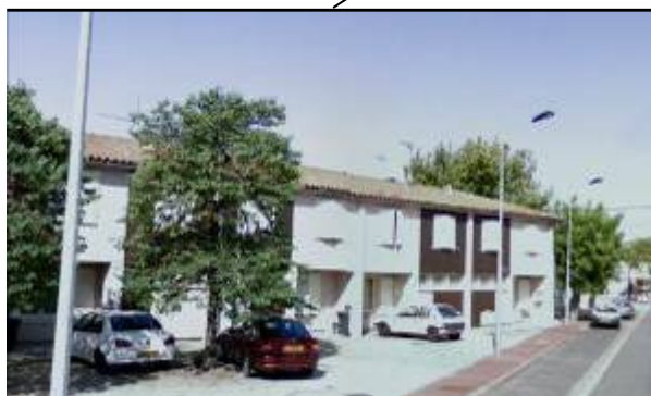
Habitat semi-collectif en R+1 construit de 1950 à 1959 et rénové en 1981. Garage individuel qui donne sur la rue.
