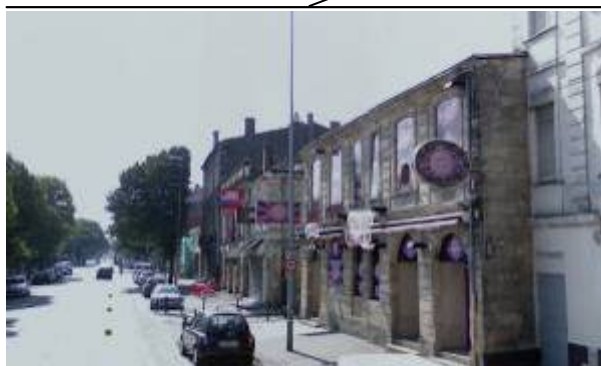
Façade de Garonne dévouée aux activités nocturnes. Grand s axes de circulation qui rompent le lien avec le fleuve. Mixité de bâti ancien avec d'anciens entrepôts réaménagés et de constructions plus récentes.
