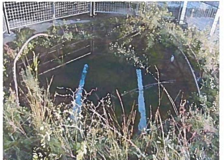
**Quelques exemples de désordres relevés sur la toiture : Flaches de rétention d'eau , végétation , trou de bombes , pare bombes effondrés**
