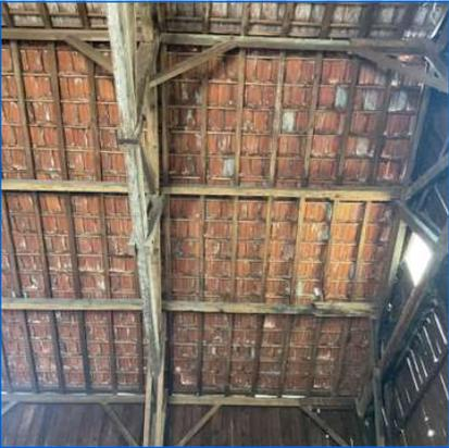
Une photographie prise depuis l'intérieur d'un bâtiment, montrant la structure de la toiture. On voit des poutres de bois et une couverture en tuiles. Certaines tuiles sont cassées ou manquantes, et il n'y a pas de pare-pluie visible.
