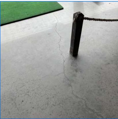
43 RDC **Dallage béton avec finition quartz: présence de fissures régulièrement espacées de 3 à 6 m.**
