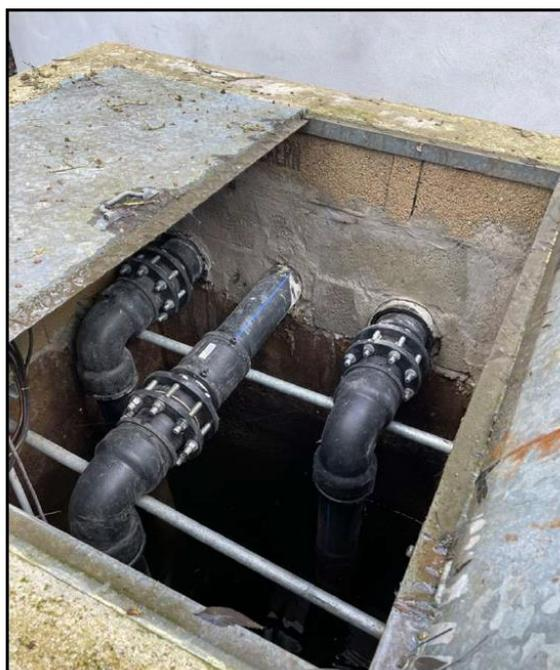
Figure 49 : Photographie des pompes d'arrosage du parcours Jalle (@CERAG 27/02/2023)
