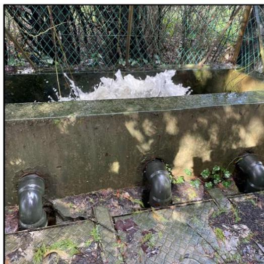
Figure 50 : Photographie des 3 pompes de vidange du parcours Etangs (@CERAG 27/02/2023)
