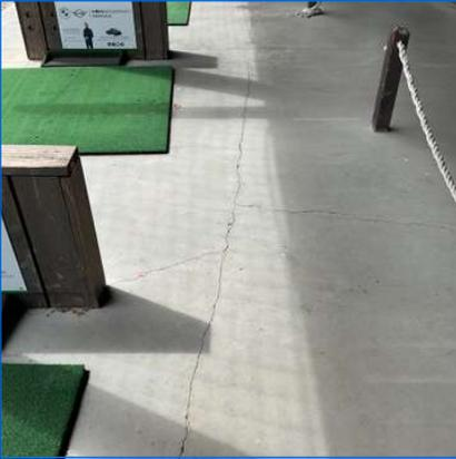
42 RDC **Dallage béton avec finition quartz: présence de fissures régulièrement espacées de 3 à 6 m.**
