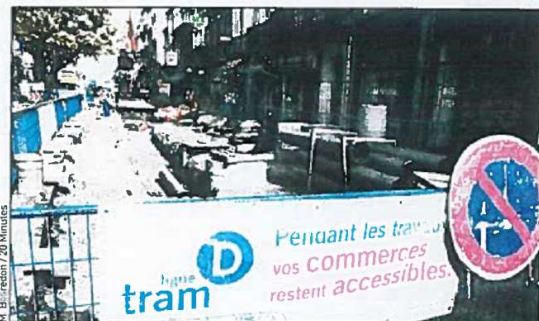
Les travaux de la ligne D du tramway ont été source de plusieurs saisines.
