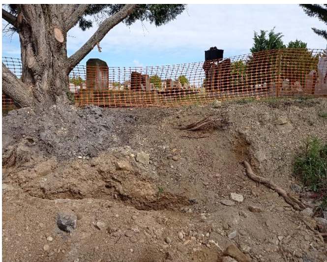
Photos n°4 et 5 : racines mutilées mises en évidence par l'excavation sur l'arbre n°5 (notéV5)
