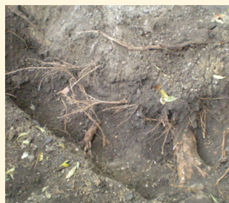
Racines endommagées par une tranchée
