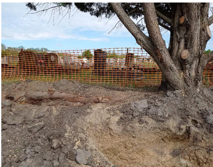
Photos n°4 et 5 : racines mutilées mises en évidence par l'excavation sur l'arbre n°5 (notéV5)
