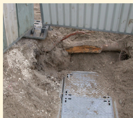
Racines endommagées par une tranchée
